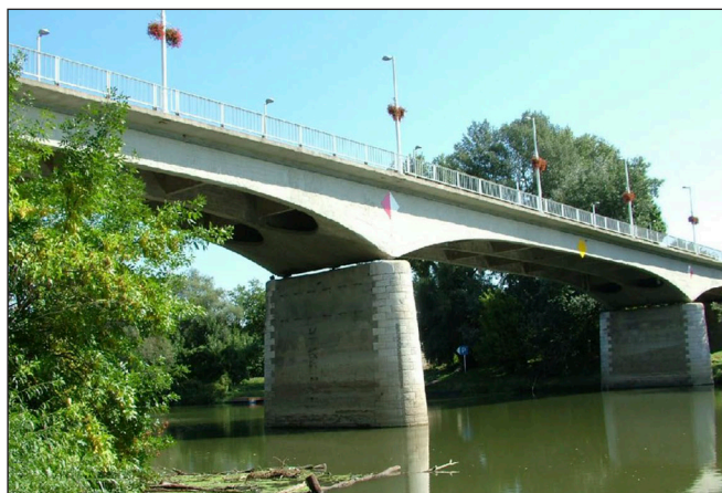
4. ábra: A sárospataki Bodrog-híd
