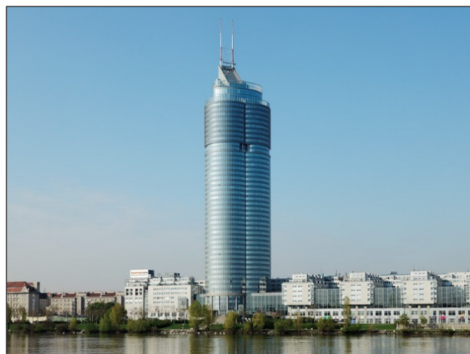
19. ábra: Millennium Tower (202 m), Bécs
